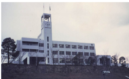
図 23 福山大学 図書館・管理棟 1980(昭和 55) 年 出典：福山大学「喜多村幸夫アーカイブ」より
