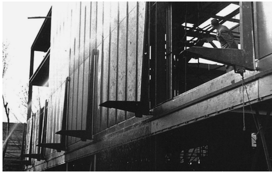
図15 クリシーの人民の家(1938)： カーテンウォールの外壁[左]と断面図解図[右] ④
