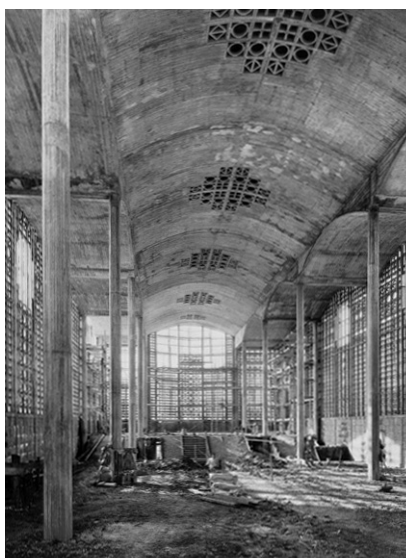
図4 建設中のル・ランシーの教会堂(1903)内部 15
