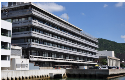
図1 旧尾道市庁舎(1960年竣工)
